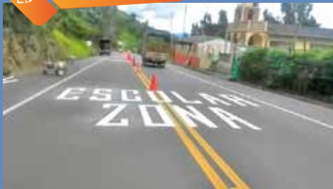
Actividades de operación y mantenimiento
