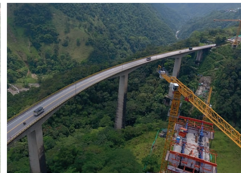
IP Chirajara-Villavicencio Construcción nuevo viaducto Pipiral
