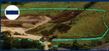
Aislamiento con polisombra de las áreas a intervenir, derecho de vía.
