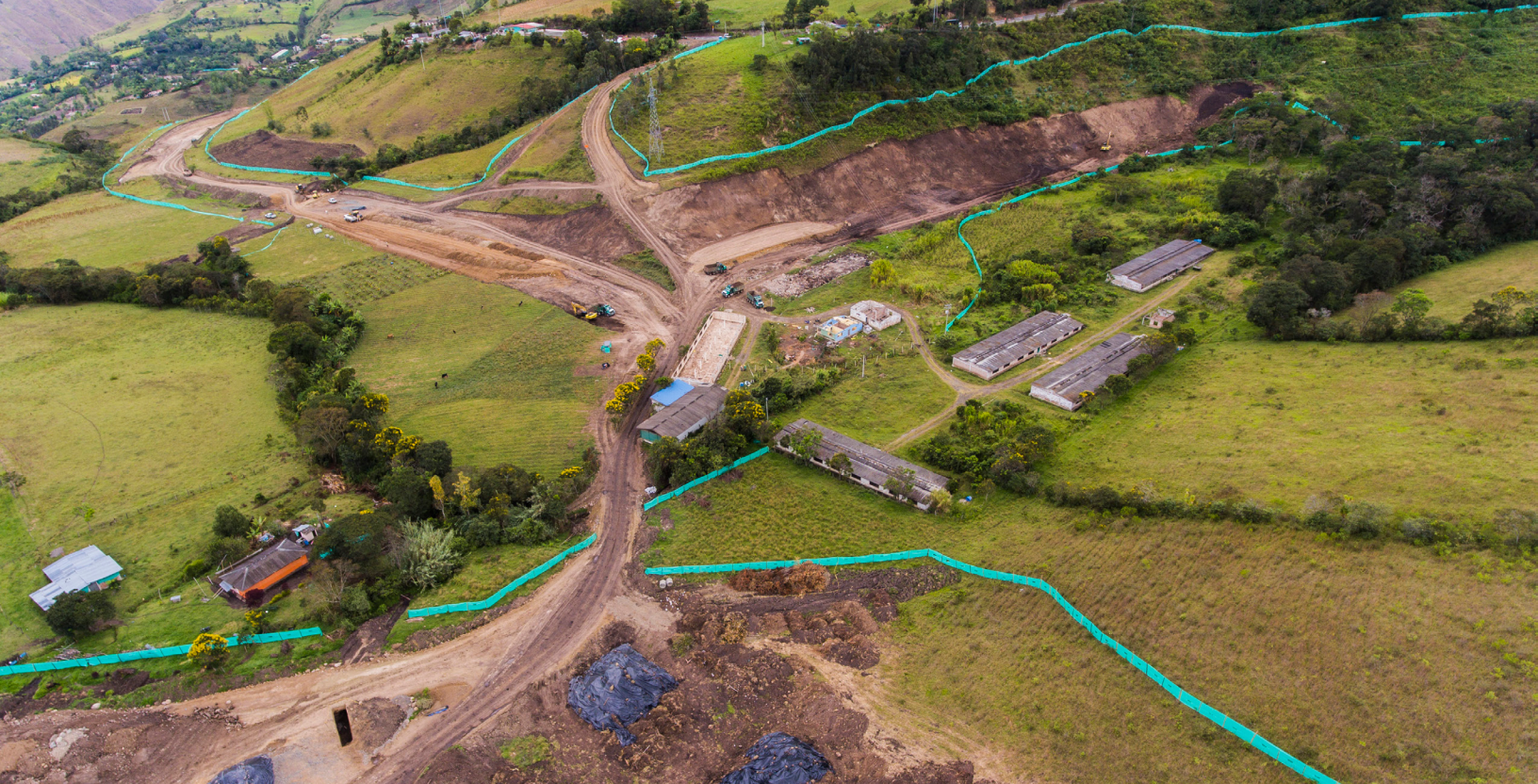
Obras para construcción de terraplén FRENTE No 4, 5, 6 y ZODME - Z4-6
