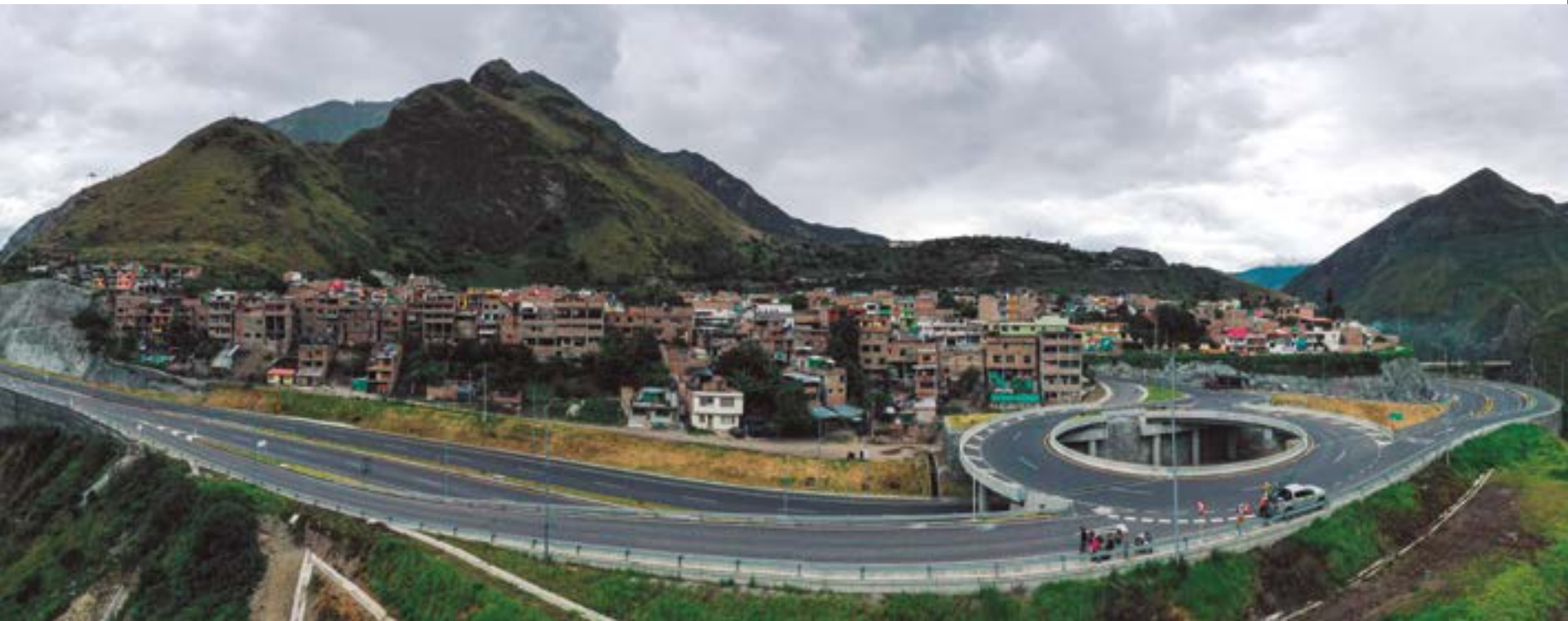
Antes de la intervención de la Concesionaria: El Pedregal.
